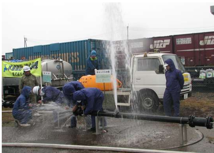
【桜島火山爆発総合防災訓練における応急復旧訓練】
