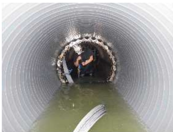
【管更生工法による污水管の長寿命化対策】
