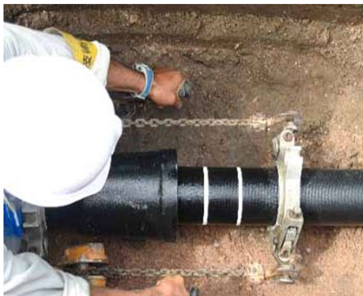
【耐震管の布設】
