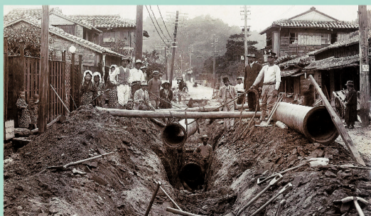
配水管布設工事（1919年）柳町付近
