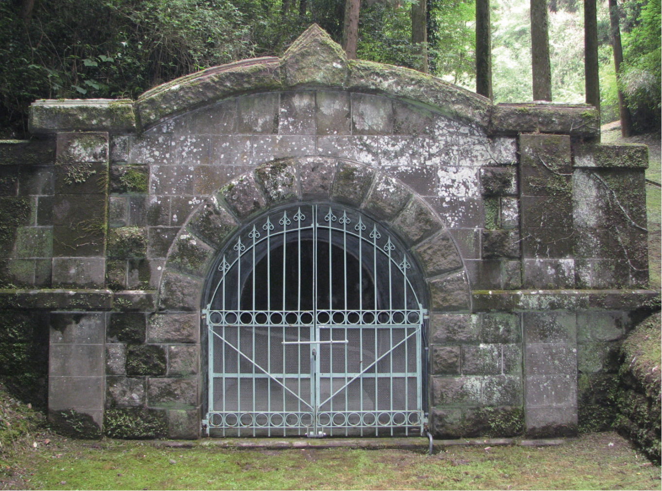
【七窪水源地】大正8年に通水、当時の施設が現在もほぼそのまま使われている。
