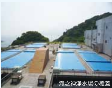
滝之神浄水場の覆蓋
