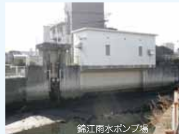
錦江雨水ポンプ場
