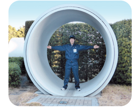
【南部幹線の汚水管】 鉄筋コンクリート製で、地下約10mの深さに埋設されています。内径2.4mで、本市最大の汚水管です。
