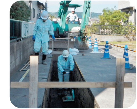
【汚水管の布設工事】 衛生的で快適な生活環境を確保するため、事業計画区域(緑色の区域)において、汚水管の整備を進めるとともに、既設管の老朽化対策に取り組んでいます。
