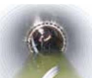
管更正工法による汚水管の耐震化
