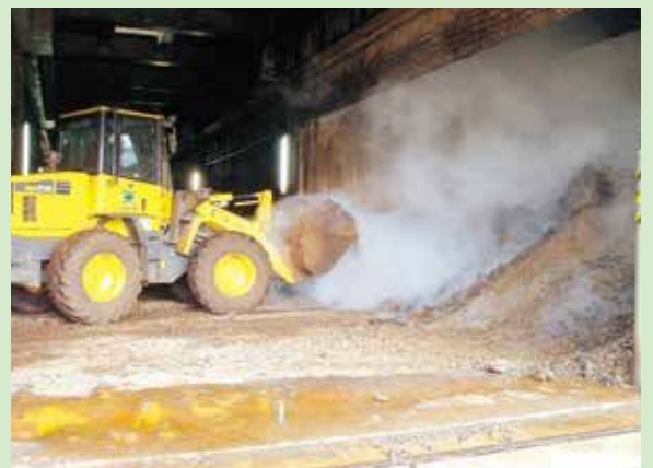
《脱水汚泥発酵中》
