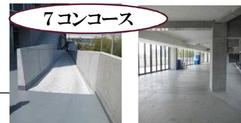
●吹田スタジアムではコンコースに車が直接到達できるようにスロープを設置している。
