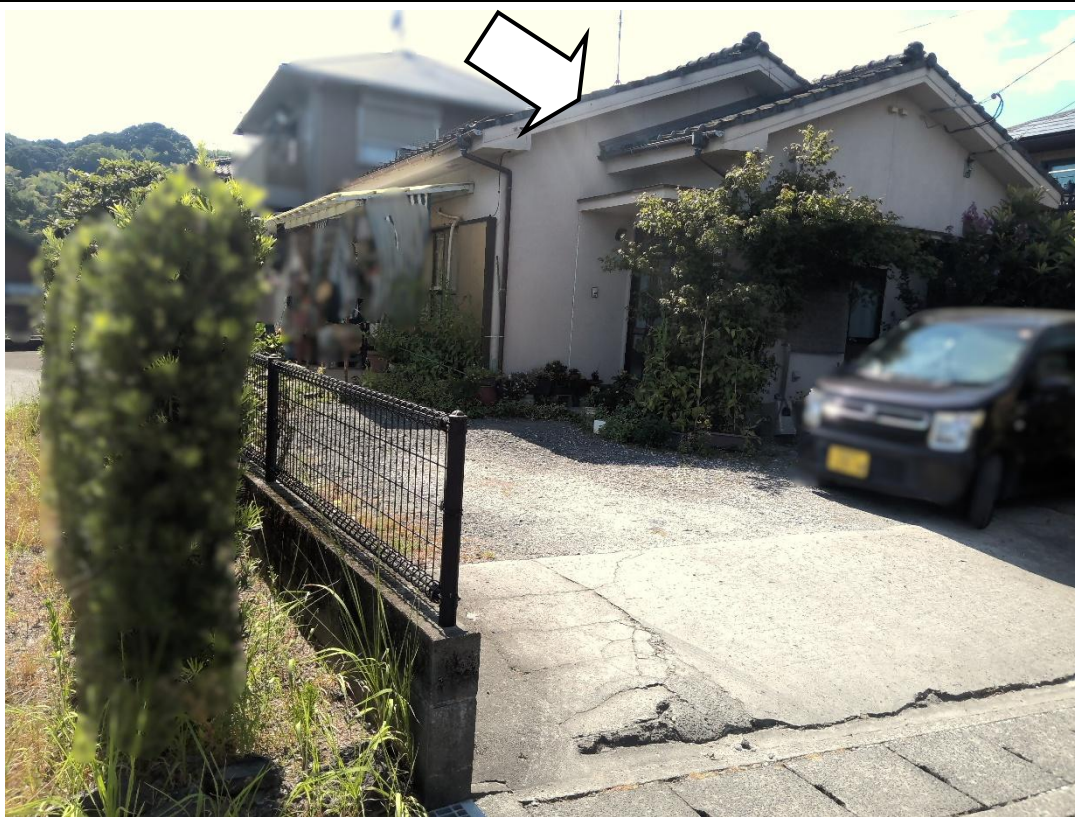
南東方から撮影
