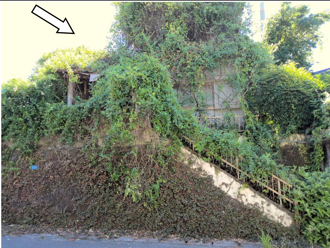
北西方から撮影（右側の階段を登った先に居宅）
