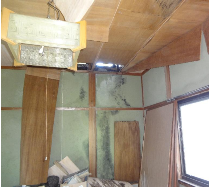
居宅の屋根部分が崩落しています
