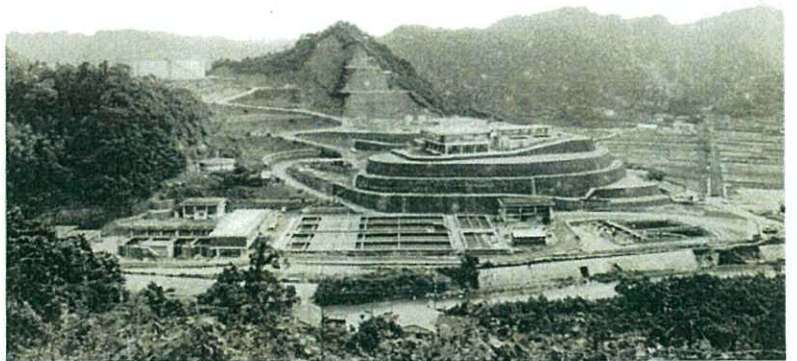
河頭浄水場整備拡張工事(昭和45年頃)
