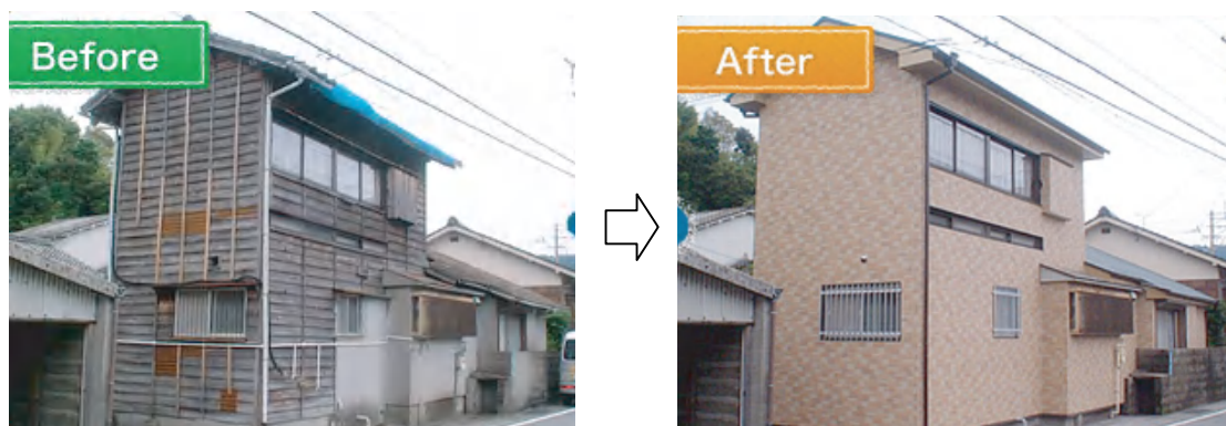
外壁改装の様子
