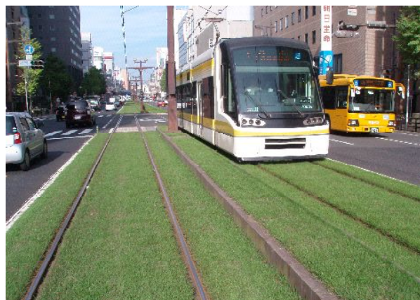
軌道敷緑化と超低床電車ユートラムII
