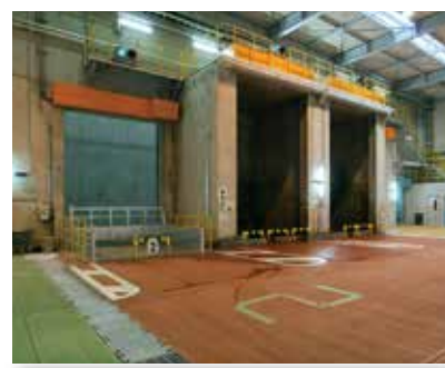
① プラットホーム
