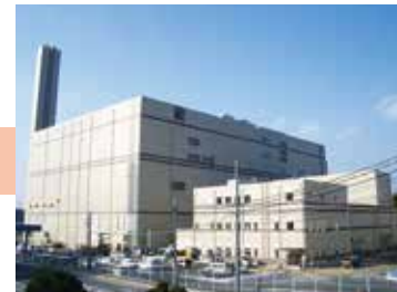
南部清掃工場 (谷山港3丁目)
