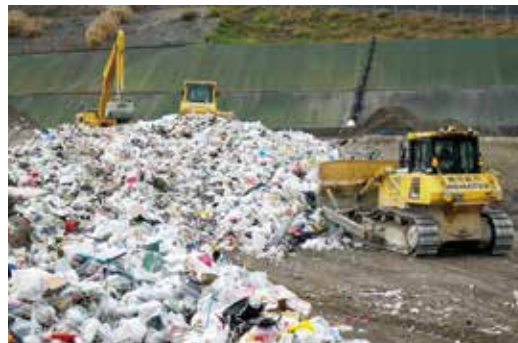
ブルドーザで平らにしている様子
