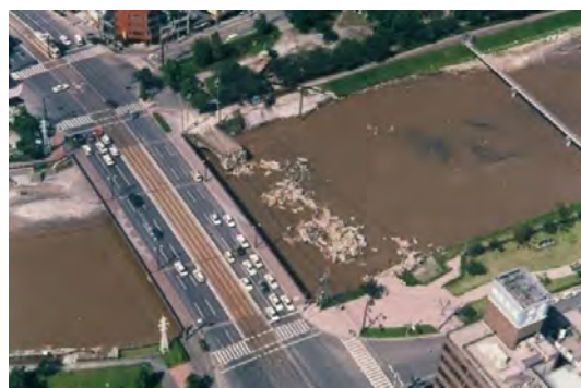
決壊した五大石橋（武之橋）
