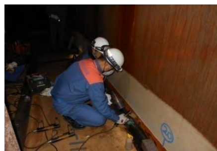
石油タンク内部の検査
