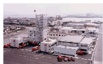
消防総合訓練研修センター
