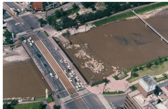
決壊した五大石橋（武之橋）
