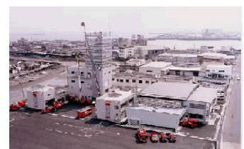
消防総合訓練研修センター
