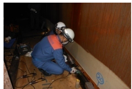
石油タンク内部の検査
