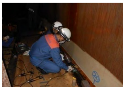
石油タンク内部の検査
