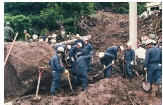
国道10号線(花倉地区)の活動状況
