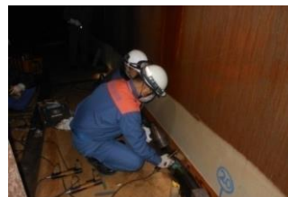
石油タンク内部の検査
