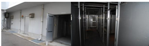
訓練センターの改修
