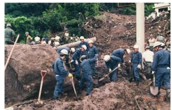
国道10号線(花倉地区)の活動状況
