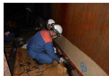
石油タンク内部検査の実施
