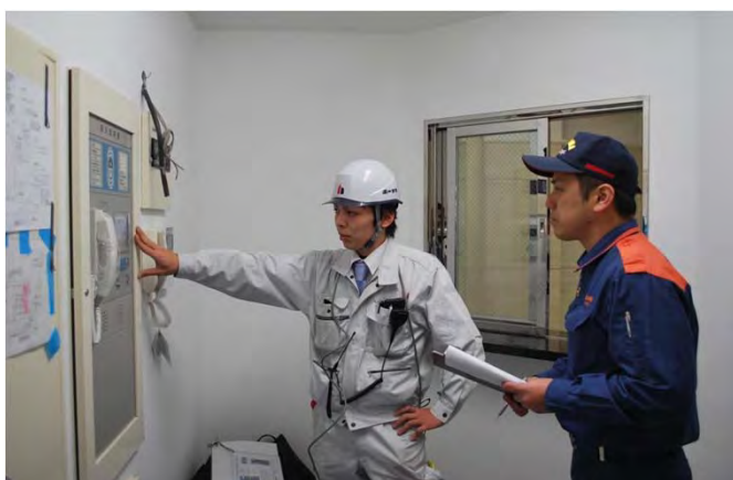
設備検査の実施
