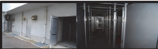
訓練センターの改修
