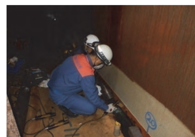
石油タンク内部検査の実施
