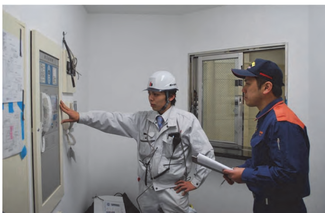
設備検査の実施
