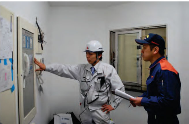
設備検査の実施
