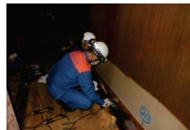
石油タンク内部検査の実施
