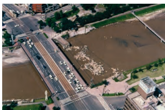
決壊した五大石橋(武之橋)
