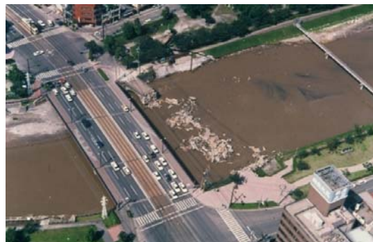
決壊した五大石橋(武之橋)
