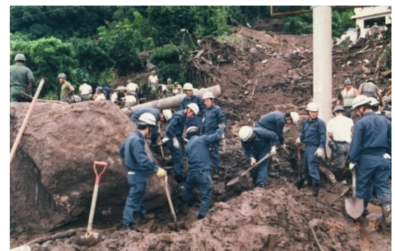
国道10号線(花倉地区)の活動状況
