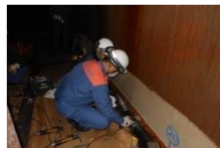
石油タンク内部の検査
