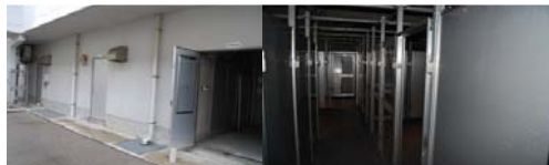
訓練センターの改修
