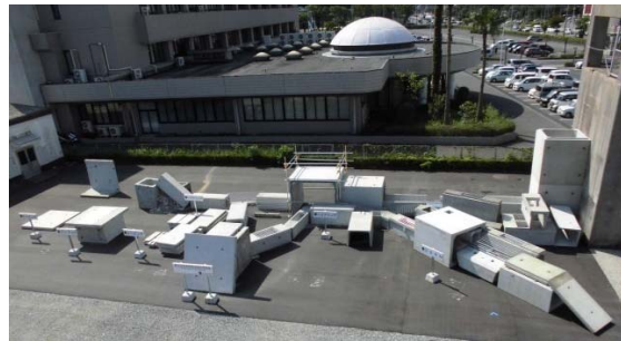
都市型搜索救助活動訓練施設 (平成27年11月設置)
