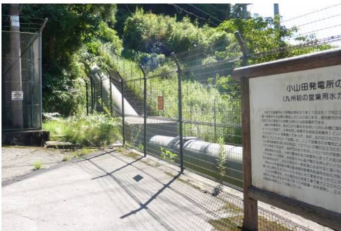
九州初の営業用水力発電所 である小山田発電所
