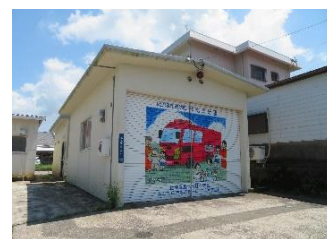
カ 牟礼岡消防分団 牟礼岡団地内での火災発生時 の消火活動や日ごろの防火活 動を行っています。(AED設置)
