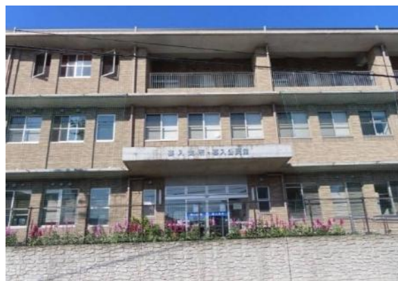
鹿児島市役所喜入支所・喜入公民館
