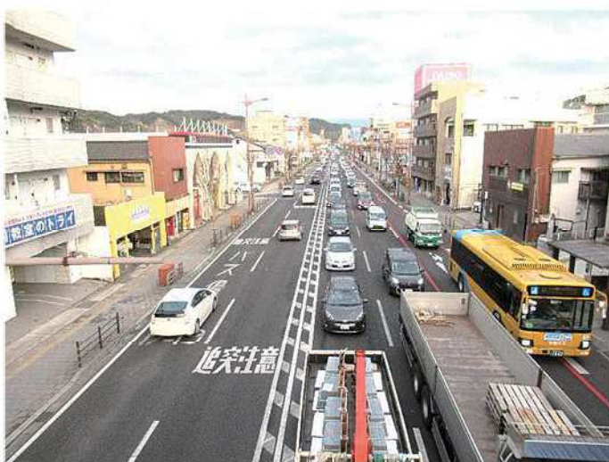
(国道3号線一下伊敷1丁目付近)
