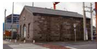
18 市交通局変電所跡
