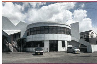
・プライムワークス建物全景
