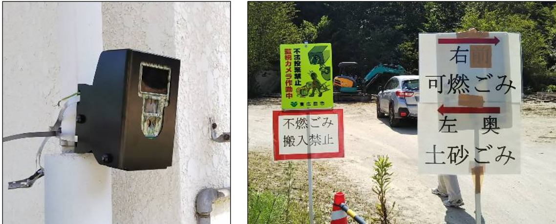
写真 3-5 仮置場に設置した監視カメラ及び看板(平成 30 年 7 月豪雨 広島県東広島市)
