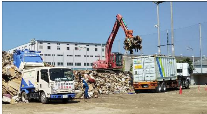
写真 3-4 仮置場内で災害廃棄物を積込む重機 (平成 30 年 7 月豪雨 広島県安芸郡坂町)
