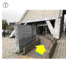
車椅子用のスロープもあります。 ※反対側の入り口にもスロープ有
