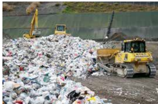
ブルドーザで平らにしている様子
