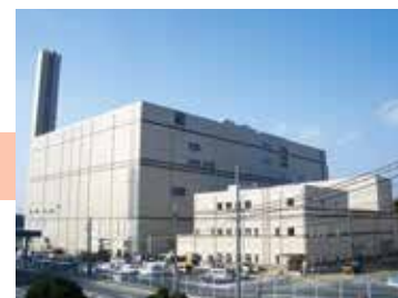
南部清掃工場(谷山港3丁目)
