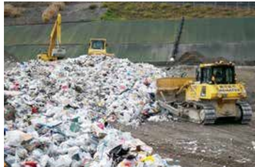
ブルドーザで平らにしている様子
