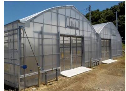
補強型ハウス
