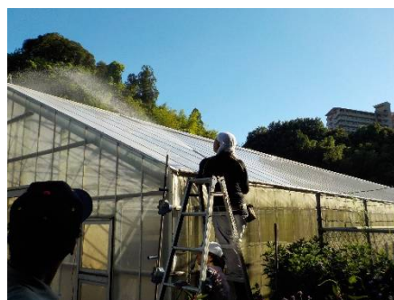
ハウス栽培での夏場の高温対策 (屋根への塗布型遮光資材の散布)
