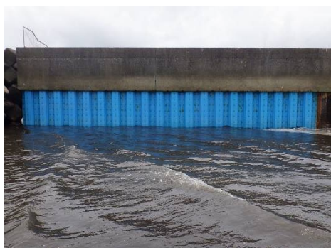
生見漁港の機能保全 (腐食防止工事による長寿命化)
