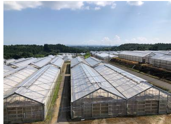
一体的に整備された硬質プラスチックハウス
