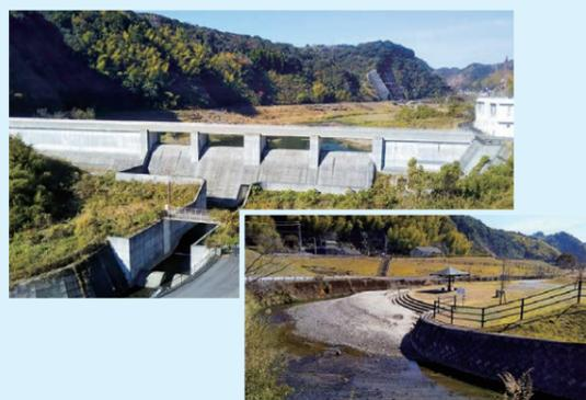
新川の上流に洪水対策として建設されたダムです。普段は川の水を貯めない流水型ダムで、湿地や川の水を引き込んだ貯水池が整備され、様々な生きものがすむビオトープになっています。また、上流の公園には新川が流れていて、水遊びや生きものさがしを楽しむことができます。
