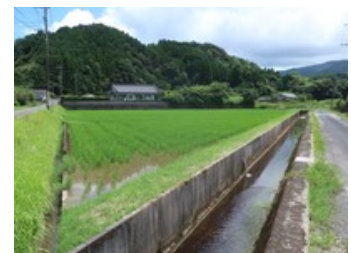
仮屋崎用水路
