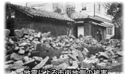
地震による市街地側の被害
