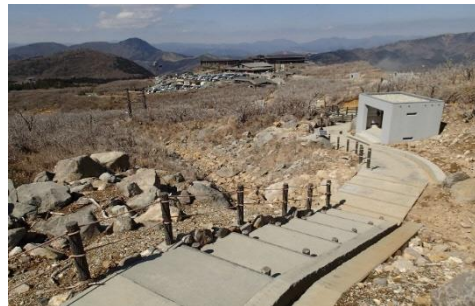
シェルター及び舗装された歩道
