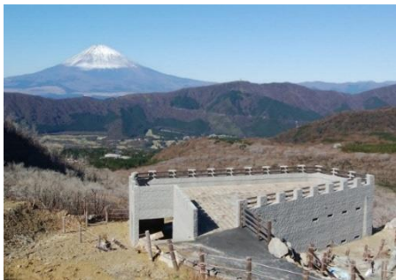
屋上展望台と なったシェルター
