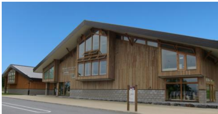
【洞爺湖ビジターセンター】
