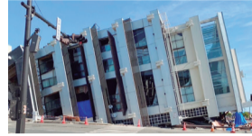
<倒壊した建物>
