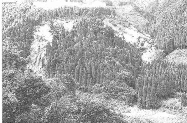
20 郡山層が滑った入来峠近くの崖崩れ(遠望)
