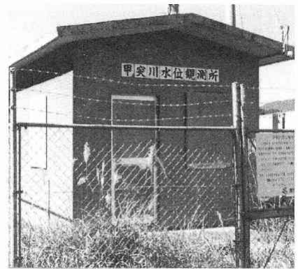
宮山橋の水位観測所(甲突)
