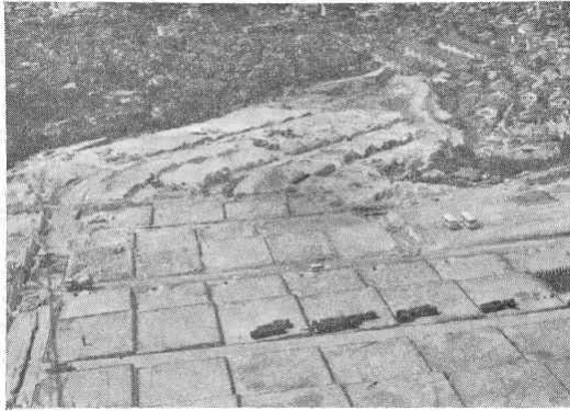
城山の宅地造成工事（草牟田町）
