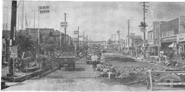
防塵舗装工事（昭和大通り）
