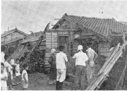
台風で破壊された家屋（郡元町）
