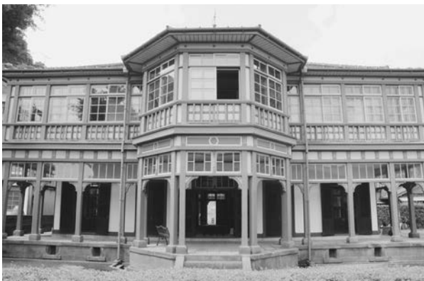
旧鹿児島紡績所技師館
