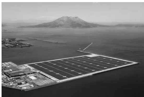
鹿児島七ツ島メガソーラー発電所
