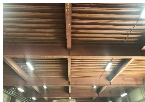
施設内照明をLEDへ
