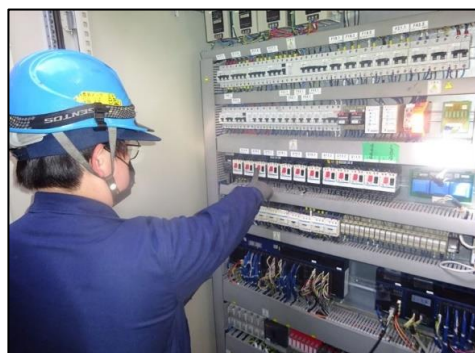
風力発電所メンテナンス作業
