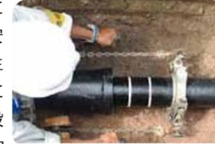
水道管(耐震管)の布設
